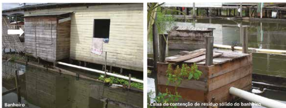
Figura 1. Sistema de coleta de esgoto de uma das casas dos casos identificados no surto de febre tifoide, Macapá/AP
