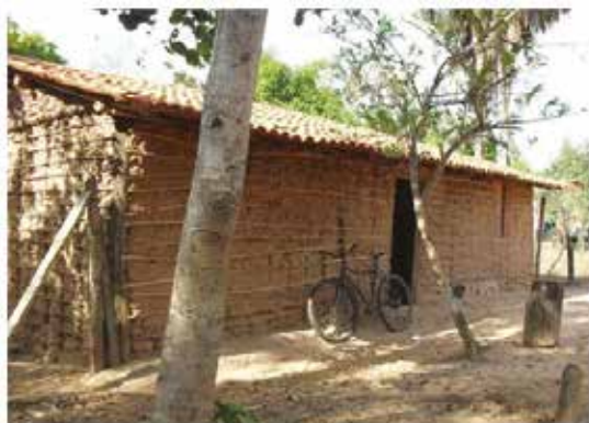
Figura 4. Casa de pau-a-pique, São Roberto, 2011
